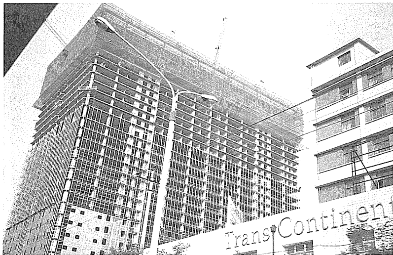
中国国営企業工事中のオフィスビル
